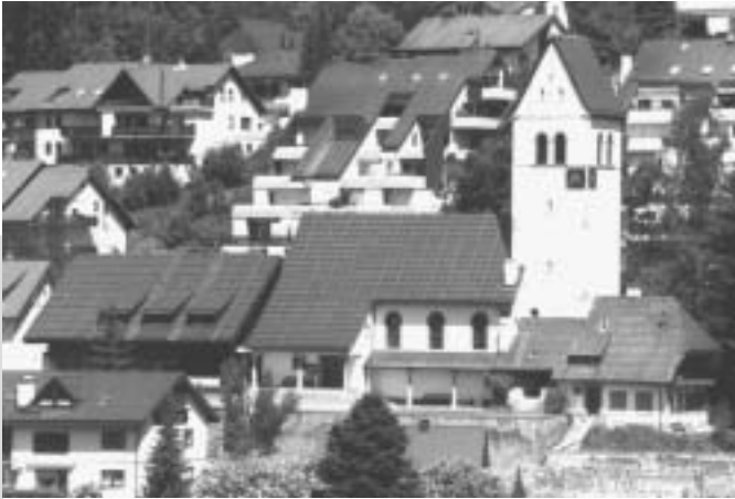
Kirchendach mit Photovoltaikanlage
